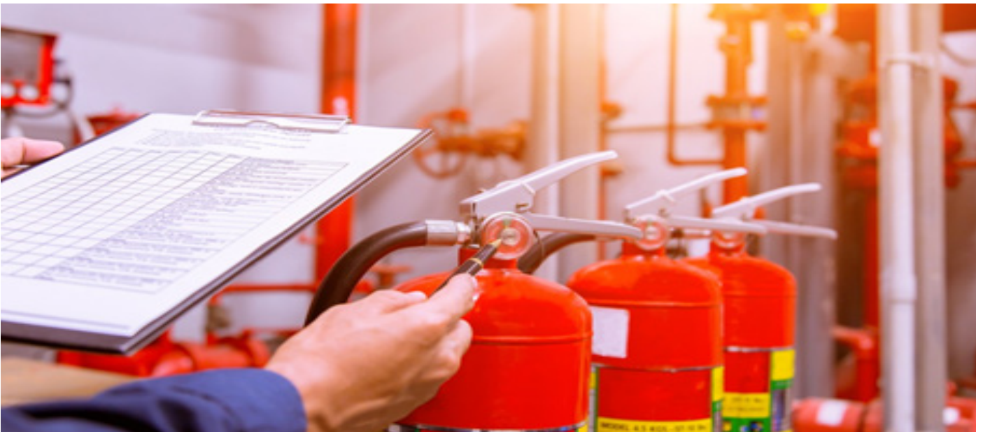
Detalhe de profissional conferindo equipamentos contra incêndio
