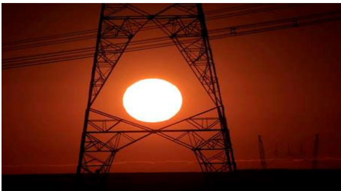
Linhas de transmissão de energia elétrica em Brasília REUTERS/Ueslei Marcelino
