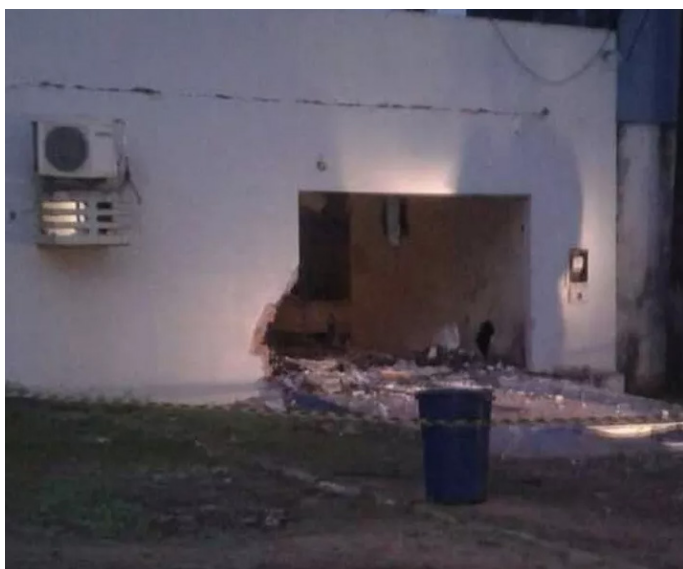
Caixa eletrônico ficava na Usina Ipojuca, às margens da PE-60
