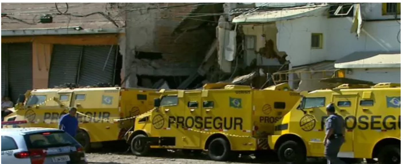
Prédio da Prosegur e imóvel vizinho ficaram destruídos em Ribeirão Preto, SP (Foto: Reprodução/EPTV)
